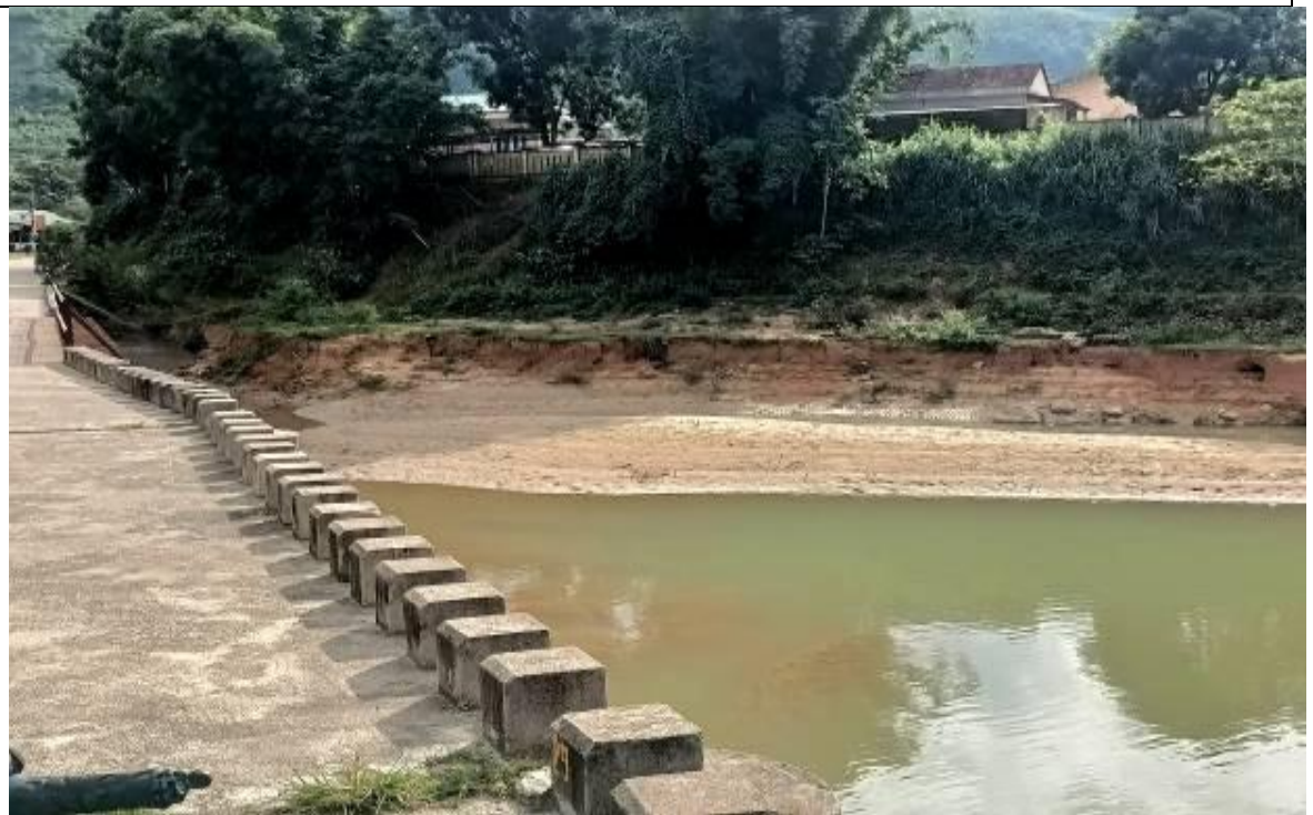
Công trình hạ tầng bờ phía Tây cầu Sơn Mùa
