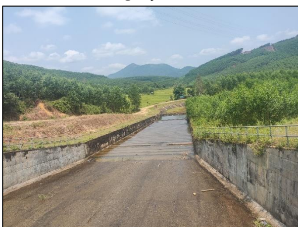
Tràn nước của đập
