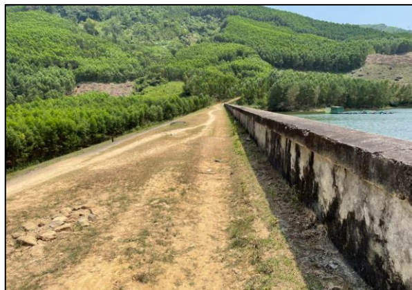
Khu vực đỉnh đập
