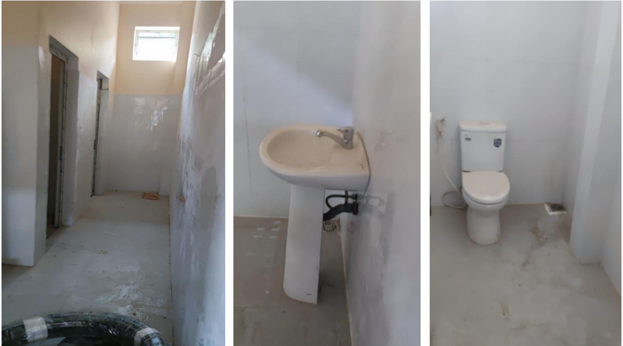
Hình 3.7: Một số hình ảnh thu và xử lý nước thải sinh hoạt tại khu nhà máy
