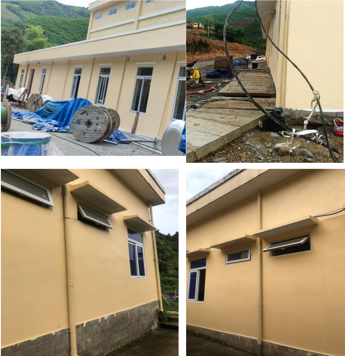
Hình 3.2: Một số hình ảnh thu thoát nước mưa tại khu vực dự án
