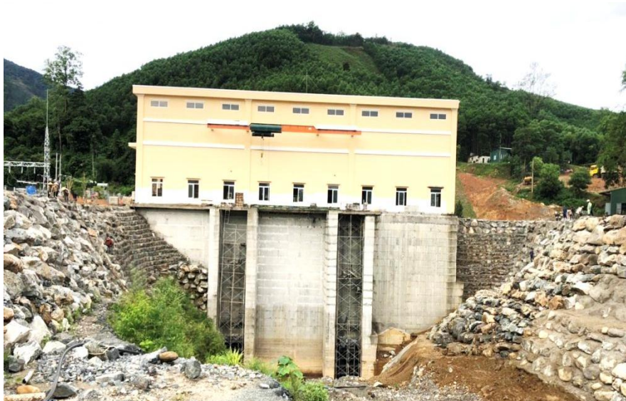
Hình 3.4: Một số hình ảnh thu thoát nước thải sản xuất tại khu vực dự án
