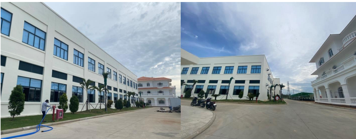
Hình 1.2. Một số hình ảnh tại Nhà máy
