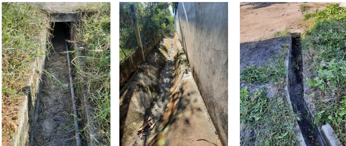
Hình 3. 2. Các công trình thoát nước mưa
